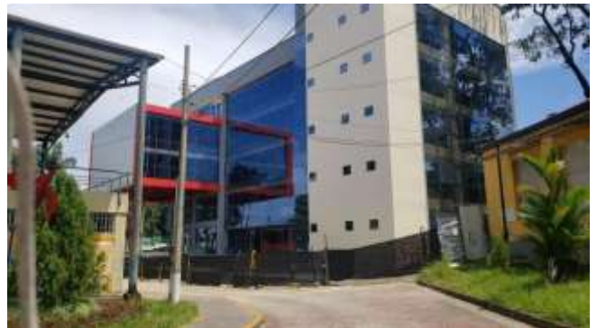
FACHADA EDIFICIO NUEVO
