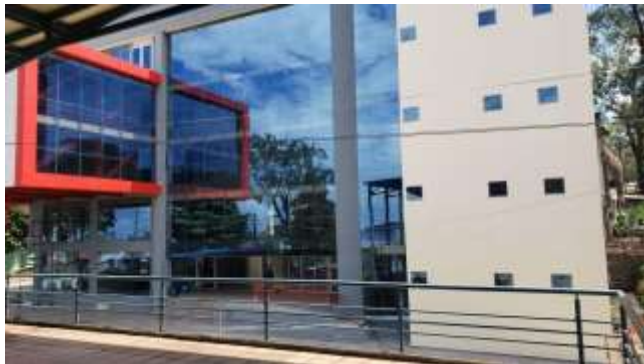
FACHADA EDIFICIO NUEVO
