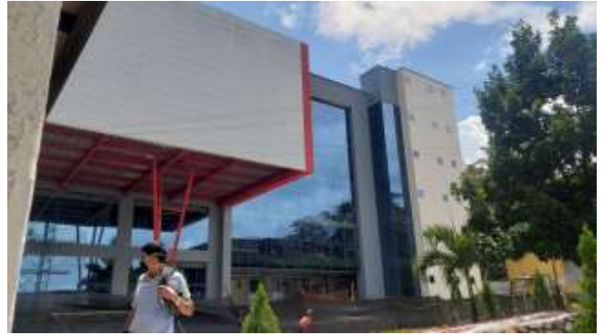
FACHADA EDIFICIO NUEVO
