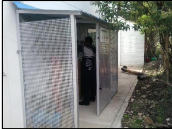
**Figura 4.** Central de cilindros en lámina perforada de acero inoxidable.
