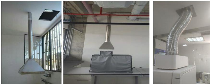
**Figura 5.** Sistema de extracción de vapores calientes y corrosivos.
